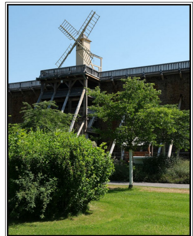
Abbildung 5: Gradierwerk mit dem rekonstruierten Antrieb der Förderpumpe oben drauf.
