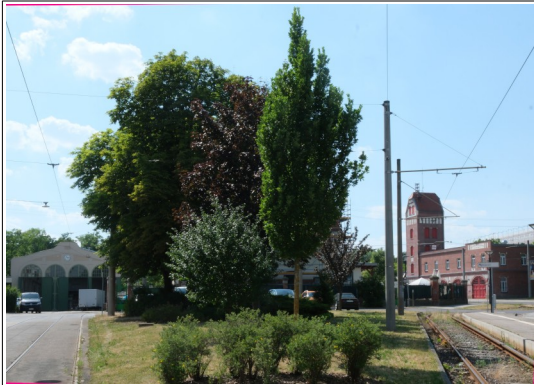
Abbildung 1: Betriebshof der LVB (links) und Feuerwache (rechts) in Schkeuditz
